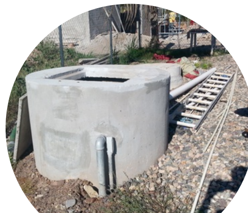
EXTERIOR DE CÁRCAMO DE BOMBEO
