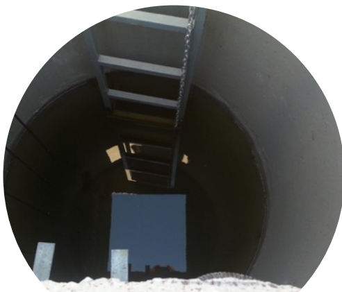
INTERIOR DE CÁRCAMO DE BOMBEO
